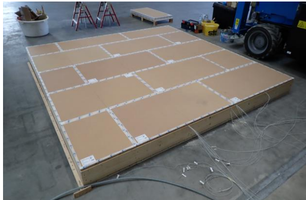
Bild A5.8: Blick auf die fertiggestellte weite Plattenlage der Bekleidung / Beplankung der feuerabgewandten Wandseite B.
