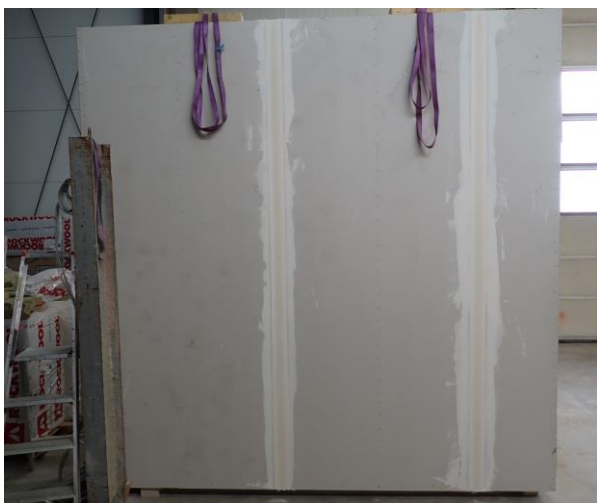
Bild A5.11: Blick auf die fertiggestellte dritte Plattenlage der Bekleidung / Beplankung der feuerzugewandten Wandseite A.
