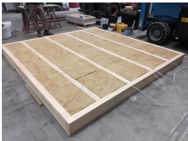
Bild A5.6: Blick auf die vollständig verbaute Gefachdämmung der 2. Ebene.
