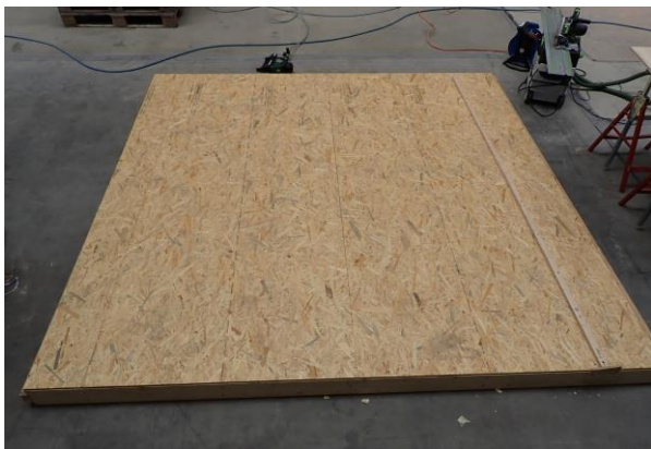
Bild A5.3: Blick auf die erste Plattenlage der Bekleidung / Beplankung der feuerzugewandten Wandseite A.
