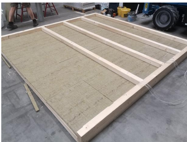
Bild A5.5: Blick auf den Einbau der Distanzhalter-Dämmung zwischen Ständerwerkebene 1 und 2 und gleichzeitiger Fixierung mit der 2. Ebene des Ständerwerkes.
