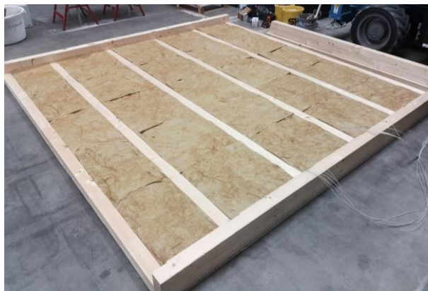
Bild A5.4: Blick auf den Einbau der Gefachdämmung der ersten Ebene.
