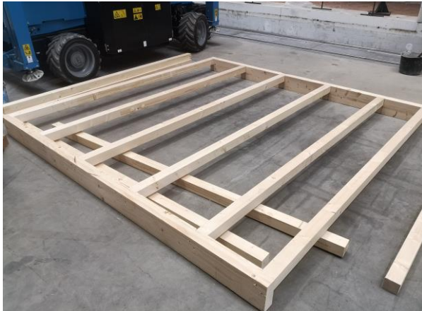
Bild A5.1: Blick auf die teilgefertigte Tragkonstruktion mit der 1. Ebene des Ständerwerkes.
