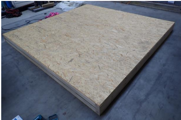
Bild A5.7: Blick auf die fertiggestellte erste Plattenlage der Bekleidung / Beplankung der feuerabgewandten Wandseite B
